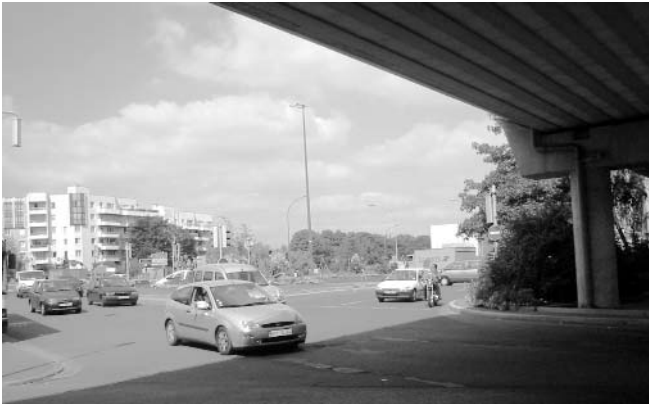
Issy-les-Moulineaux, place de la Résistance, 16 août 2005. Passé le pont du tramway, le ciel se dégage...
